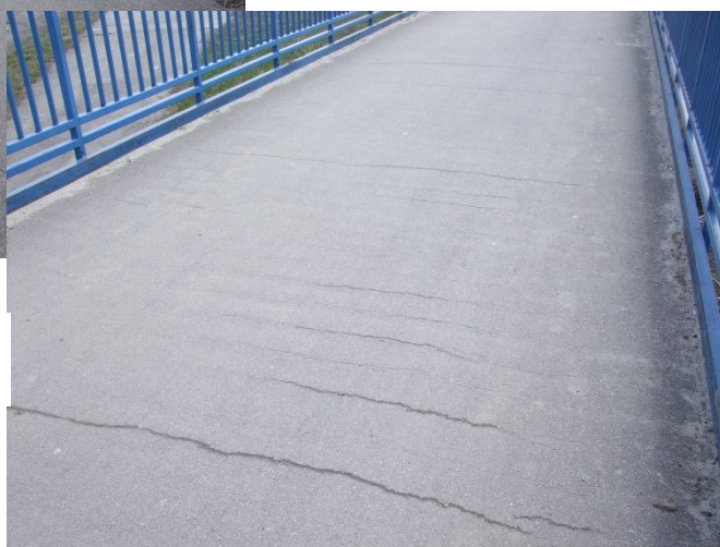
Uszkodzenia nawierzchni bitumicznej kładki w postaci spękań i rys
